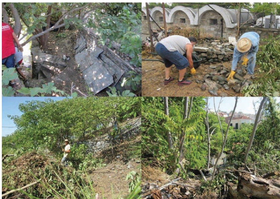
Εικ. 11: Στιγμιότυπα των εργασιών καθαρισμού με την εγκατάσταση του συνεργείου.
